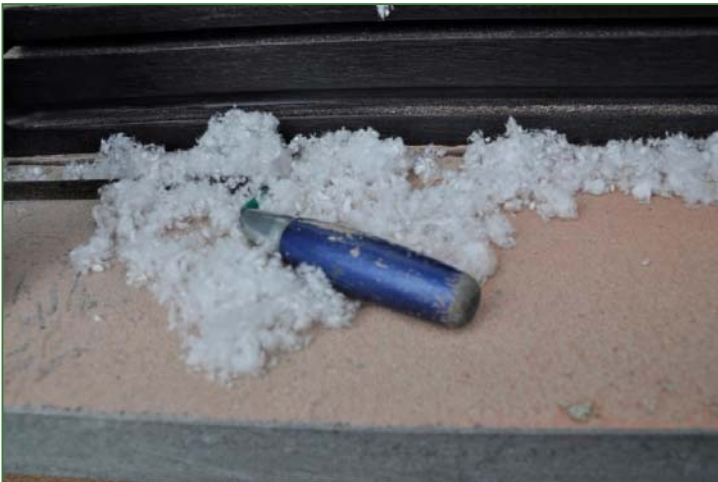
Foto links boven: Het opvullen van de boorgaten met mortel. Rechts boven: De inblaasmachine voor de glaswolvlokken. Onderaan: Glaswolvlokken als isolatiemateriaal.
