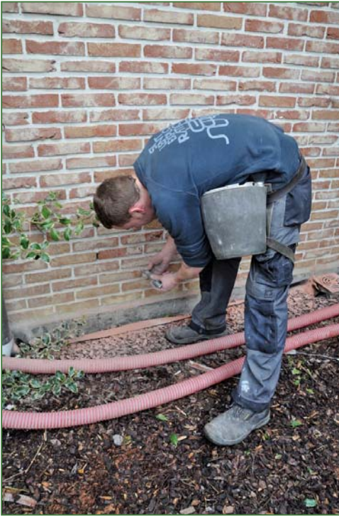
Foto links boven: Het opvullen van de boorgaten met mortel. Rechts boven: De inblaasmachine voor de glaswolvlokken. Onderaan: Glaswolvlokken als isolatiemateriaal.
